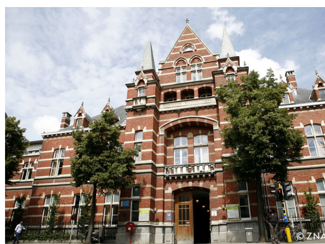
↑ Stuijvenberg, ancien hôpital en cours de reconversion
